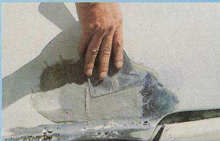
3. Boucher les creux avec du mastic polyester armé (séchage : 50 minutes).
