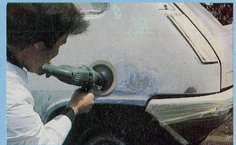
4. Dégrossir le ponçage au disque n° P 60.
