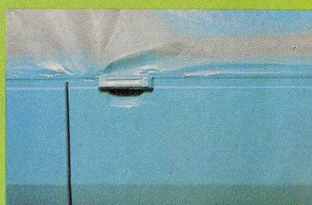
10. Passer un tampon d'essuyage avant de peindre. Pulvériser un voile de laque puis une couche simple. Laisser sécher 5 minutes et terminer par une couche croisée.
