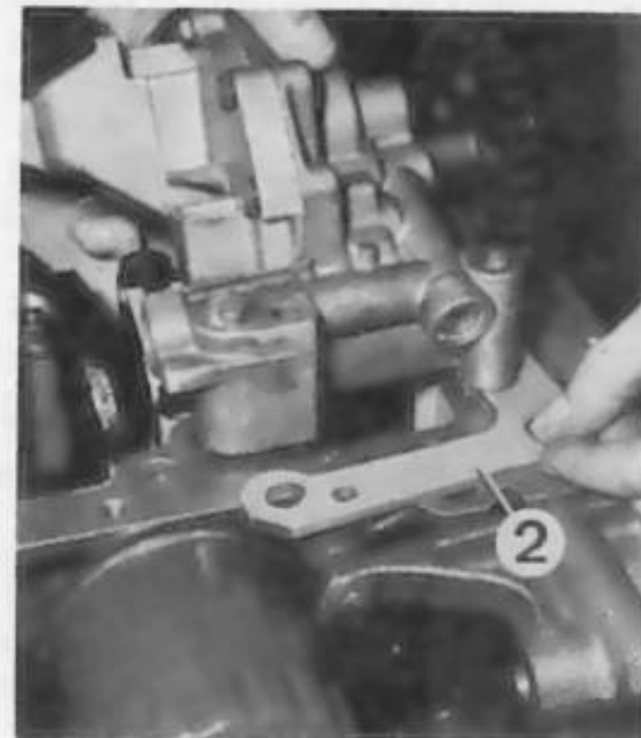
Dépose de la cale en L (2) sous la pompe à huile
